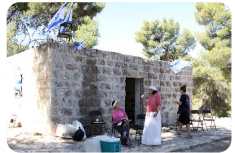
Een oud en vervallen Jordans huis wordt gerenoveerd.
